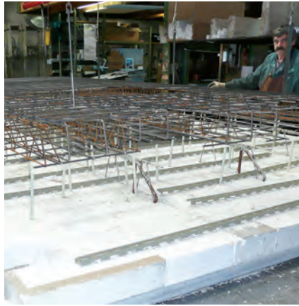
Einbringen weiterer Bewehrungslagen
