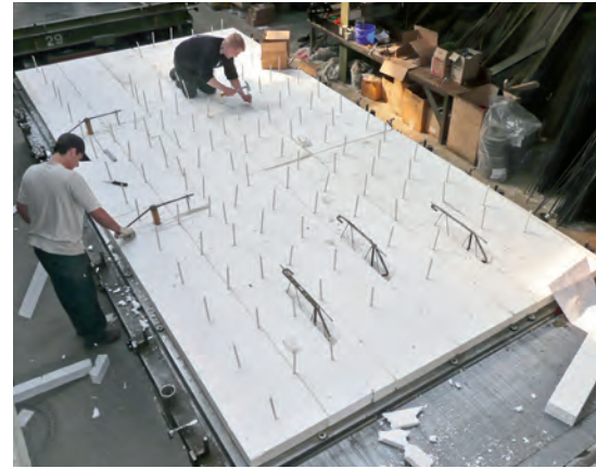
Einsetzen der Thermoanker in die Wärmedämmung
