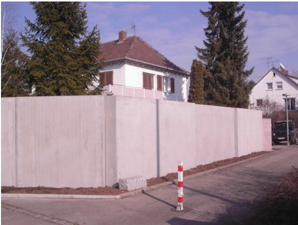
Wand nach Abschluss der Montage.
